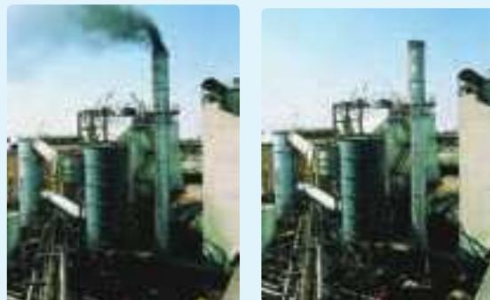
رسوب دهنده الکتروستاتیکی (ESP)<sup>۱</sup> دود و غبار را از گازهای زائدی که از دودکش کارخانه‌ها و نیروگاه‌ها بالا می‌آید جدا می‌سازد. رسوب دهنده‌ها انواع مختلفی دارند. در مورد اساس کار این رسوب دهنده‌ها تحقیق کنید. شکل‌های رو به رو تأثیر رسوب دهنده را در کاهش آلودگی هوای ناشی از یک دودکش نشان می‌دهد.
