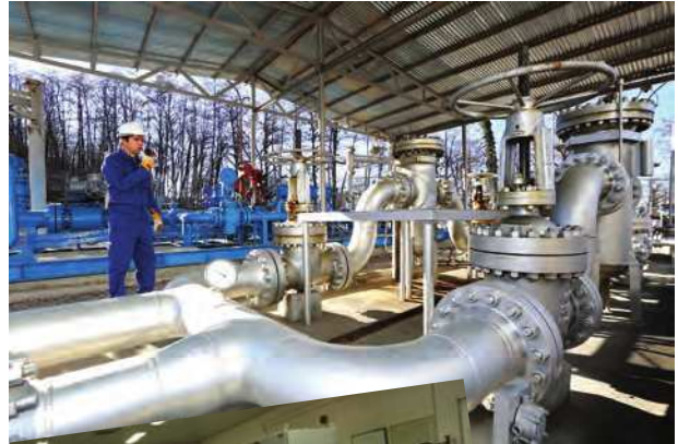
منطقه شمال - ایستگاه فشارشکن لاجیم
