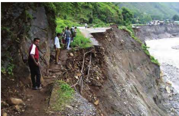
لغزش در اثر زیربُری رودخانه در هند
