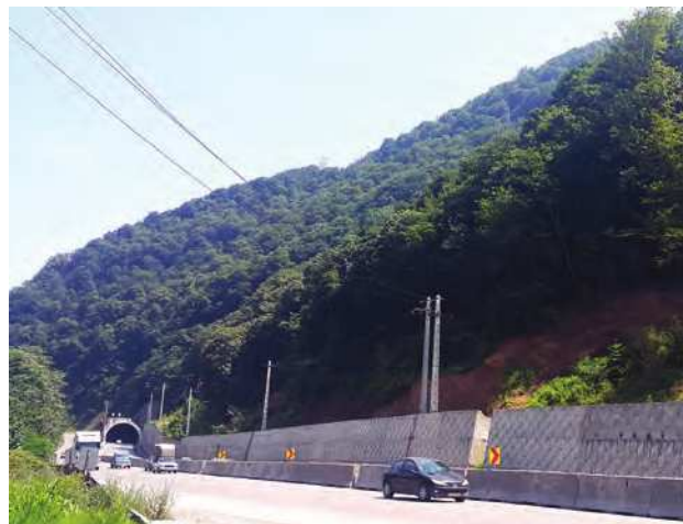
نصب حفاظ بتونی - جاده قائم‌شهر
