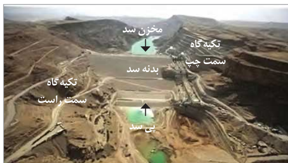
شکل ۴-۵- نمایی از بخش‌های مختلف یک سد
