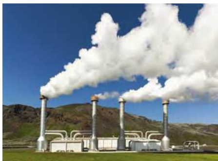
شکل ۱۱-۶- نیروگاه زمین گرمایی مشکین شهر- اردبیل
