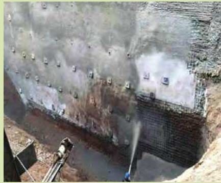
پایدارسازی شیب به روش میخ کوبی
