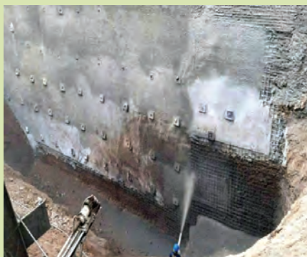
پایدارسازی شیب به روش میخ کوبی
