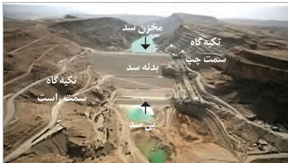
شکل ۵-۴- نمایی از بخش‌های مختلف یک سد
