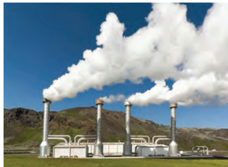
شکل ۱۱-۶- نیروگاه زمین گرمایی مشکین شهر - اردبیل
