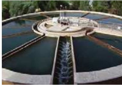
آب در تصفیه‌خانه
