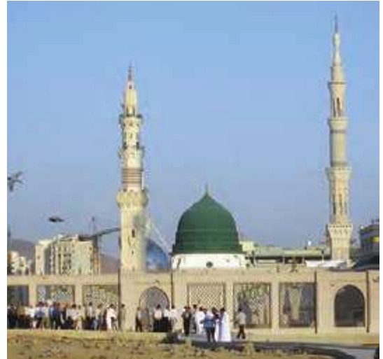
▲ مسجد النبی، نمای بیرونی
